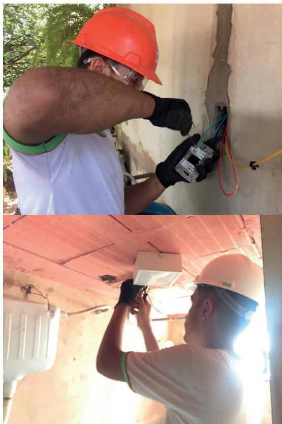
Figura 5 – Reforma Elétrica: instalação elétrica das tomadas e iluminação
