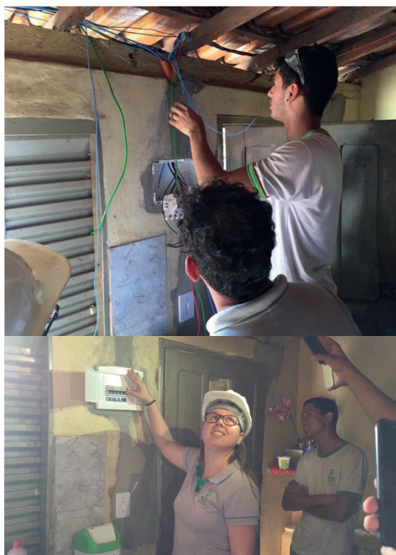
Figura 6 – Reforma Elétrica: instalação do quadro de distribuição geral e teste final.
