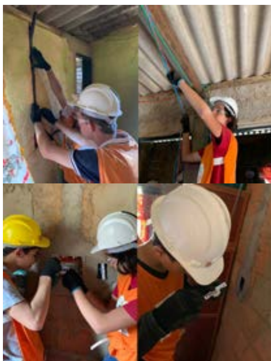
Figura 28: Imagens da execução da reforma elétrica nas residências.
